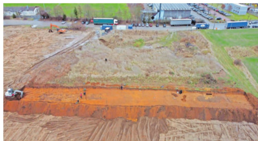
Stück für Stück wird zunächst die oberste Schicht Erde abgetragen.
