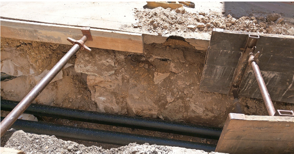
Bruchsteine am Leitungsgraben: Sie gehörten zum Fundament des Vortores am Judentor.
