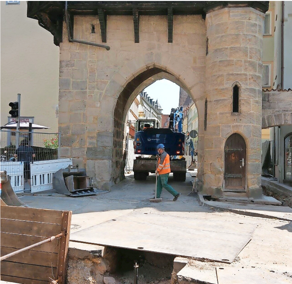
Vor und unterm Judentor werden neue Leitungen für Gas, Wasser, Strom, Fernwärme sowie Abwasserkanäle verlegt. Soweit es geht, werden dafür vorhandene Gräben genutzt.
